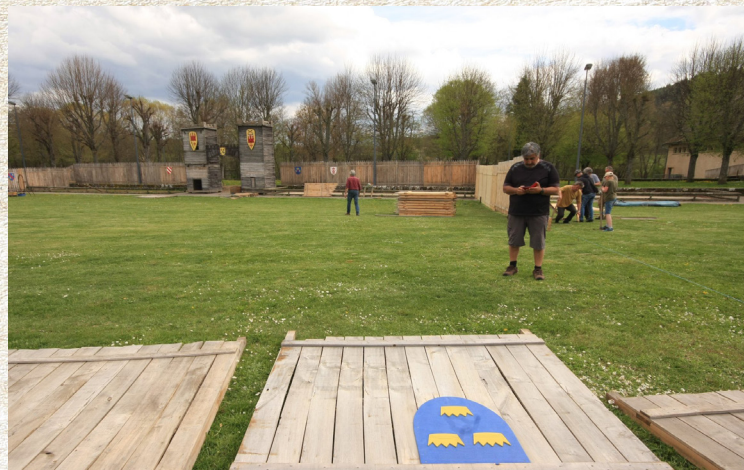
Montage des palissades de l'espace spectacle
